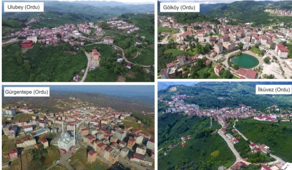
Şekil 4. DKH’da yüksek bölgelerde bulunan ve içinden küçük (çoğunlukla kuru) derecikler haricinde akarsu geçmeyen bazı yerleşimler (URL-6,7,8,9). Bu yerleşimlerde şiddetli yağışlarda yağmursuyu drenajı yönüyle sorun çıkması halinde şehir selleri ve vadi selleri meydana gelebilmektedir.
