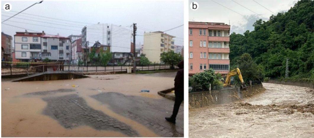
Şekil 5. 10 Temmuz 2023 tarihinde Bulancak’ta İncivez Deresi’nin taşması (a) ve Piraziz’de Abdal Deresi’nde taşkından sonra yataкта su seviyesi düşünce şehre dolan suyun taş duvarlardaki barbakanlardan dereye boşalması yavaş olunca duvarda kepçe ile boşluk açılması (URL-4,9).
