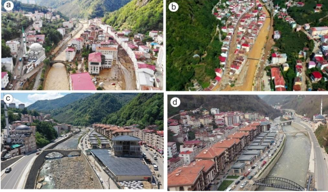
Şekil 7. Giresun'un Dereli ilçesinde 22 Ağustos 2020 tarihinde meydana gelen taşkından hemen sonra (a ve b) ve Yeni Dereli Projesi adı altında gerçekleştirilen iyileştirme çalışmaları (eski konutların yıkılıp yenilerinin inşa edilmesi, akarsu yatağında ve köprü açıklıklarında genişletme vb) sonrası (c ve d) durumu gösteren fotoğraflar, a ve c akış yukarıya, b ve d akış aşağıya bakış (URL-18,19,20,21)
