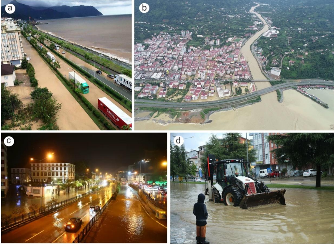
Şekil 9. DKH'ndaki bazı sahil yerleşimlerinde şehir seli ve KSY'nun bariyer etkisi (a: Artvin-Hopa'da KSY'nun 25 Ağustos 2015'te su altında kalması, b: Arhavi'de 22 Temmuz 2021 tarihli taşkın ve KSY arkasında su içindeki şehrin görüntüsü, c: 3 Eylül 2023 günü akşam saatlerinde şiddetli yağış sonucu Giresun Atapark önünde KSY'nda yağış sularının birikmesi, d: 11 Ağustos 2024 tarihinde meydana gelen şiddetli yağışta Ordu merkezde işlek caddelerden birinin durumu, URL-28,29,30,31)
